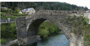
km 98 Pont de Barre
